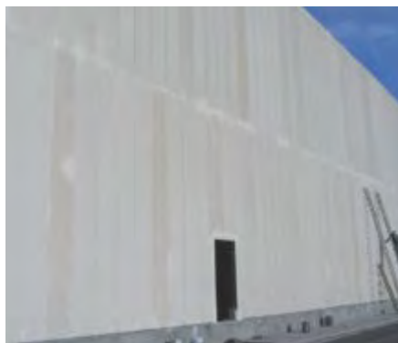
Fig. 26: Vista exterior antes del acabado final.
