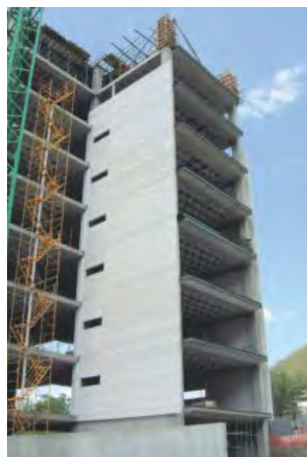
Fig. 2: Edificio de departamentos.
