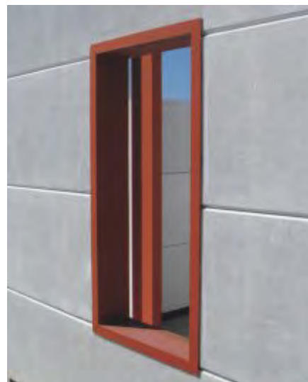
Fig. 29: Marco para vano de puertas o ventanas.
