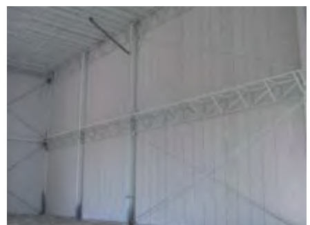
Fig. 22: Vista interior de panel en arreglo vertical.
