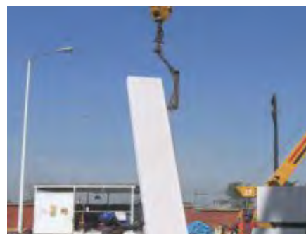
Fig. 16: Izar lentamente el panel hasta la posición de instalación.
