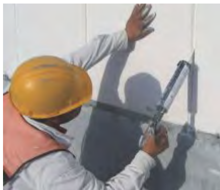
Fig. 24: Sellado de junta vertical exterior entre paneles.
