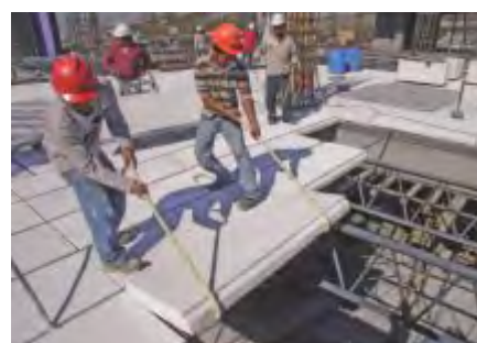
Fig. 9: Una vez colocado el panel se retiran las cuerdas y se empuja a tope con el anterior.
