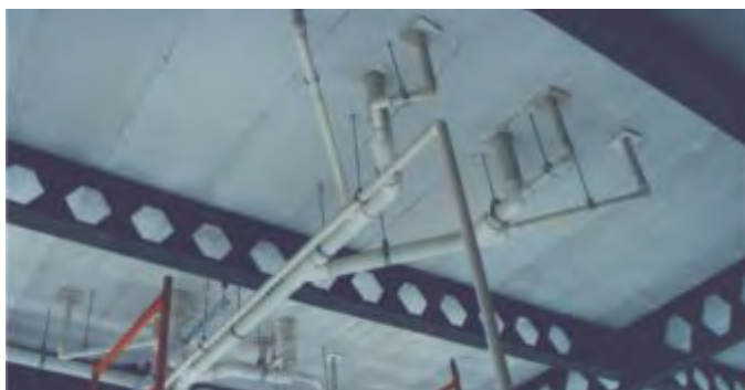
Fig. 20: Instalaciones sanitarias en nivel inferior de losa.
