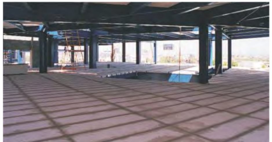
Fig. 25: Junta superior entre paneles coladas y afinadas.
