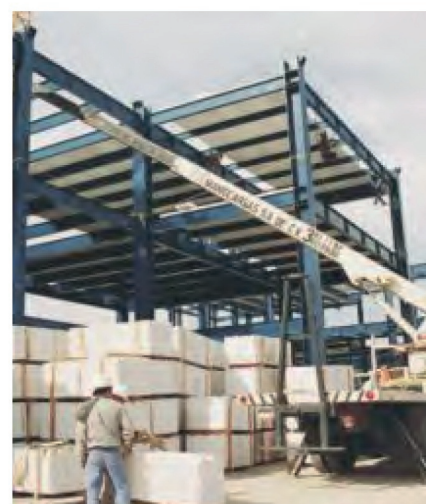
Fig. 2: Almacenamiento de panel Hebel en obra.
