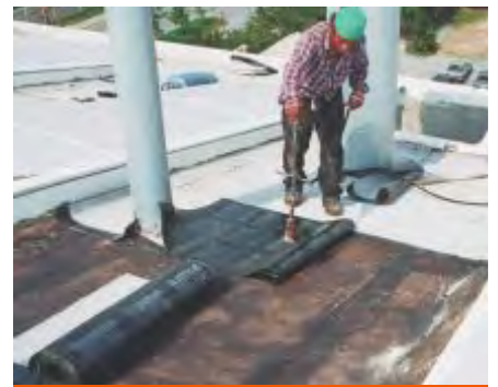
Fig. 22: Impermeabilización de membrana.
