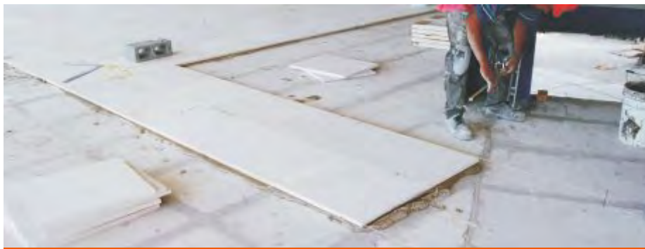
Fig. 21: Colocación directa de piso sobre panel Hebel.
