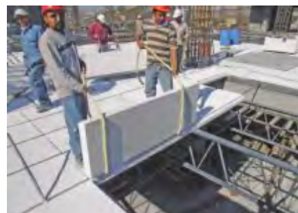
Fig. 7: Acercar el panel a su posición final en losa.
