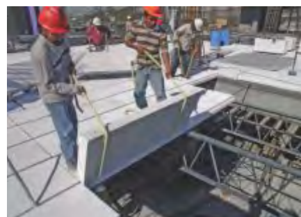
Fig. 8: Volteo del panel con cuerda (notese la posición del panel para facilitar la instalación).
