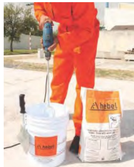
Fig. 2: Preparación de Adhesivo Hebel.
