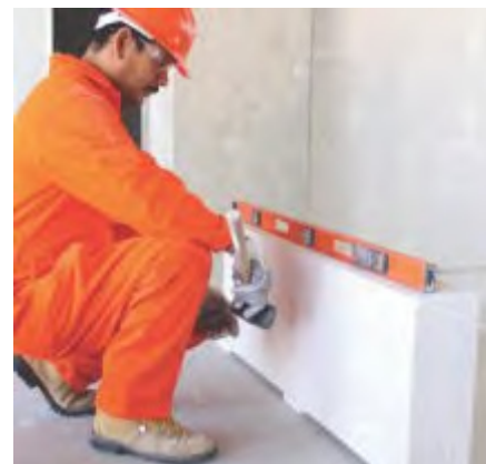
Fig. 4: Iniciar el desplante, colocando calzas.
