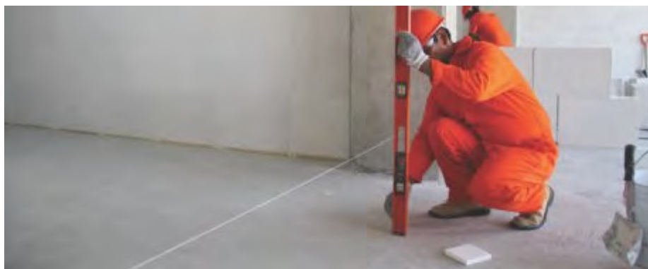
Fig. 3: Trazo y plomo para desplante.
