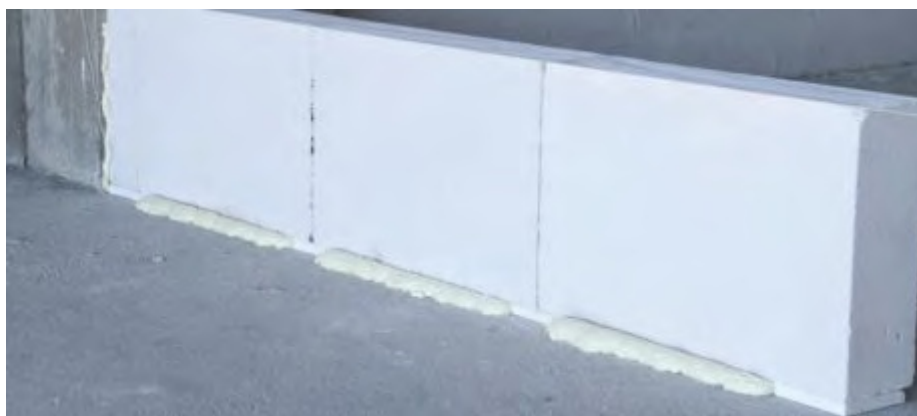
Fig. 6: Expansión de espuma de poliuretano en desplante.
