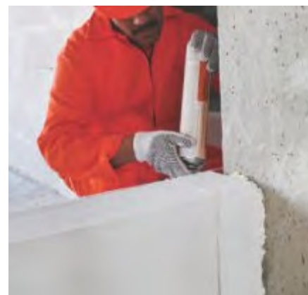
Fig. 5: Espuma Hebel en cara vertical.
