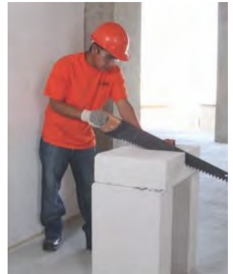
Fig. 9: Corte con serrucho Hebel.
