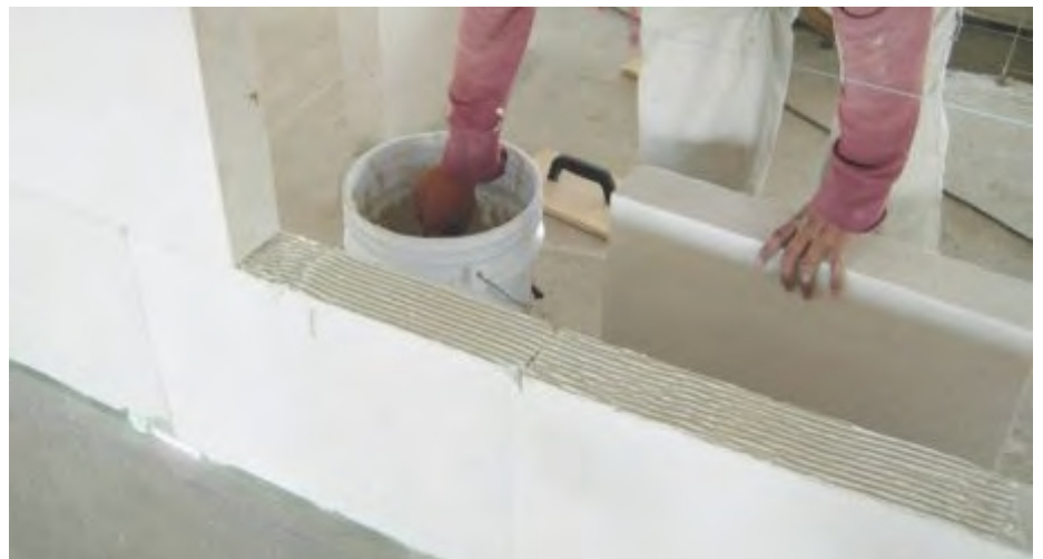
Fig. 8: Aplicación de Adhesivo Hebel.
