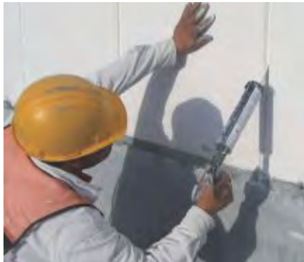
Fig. 24: Sellado de junta vertical exterior entre paneles.
