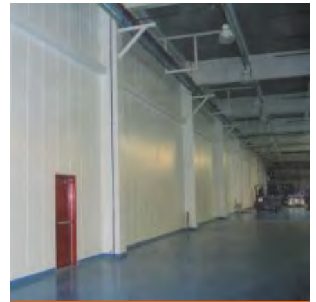
Fig. 31: Vista interior de panel para muro en arreglo vertical con acabado final.
