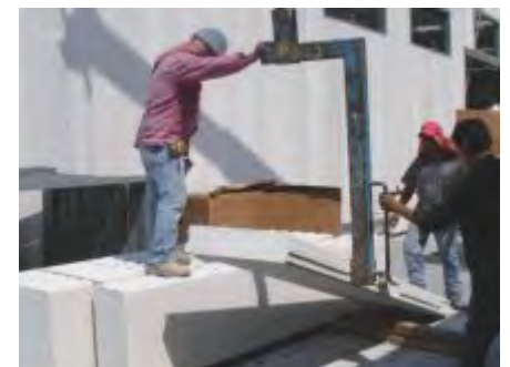
Fig. 15: Colocación del gancho G90 por el lado macho.
