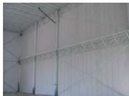
Fig. 22: Vista interior de panel en arreglo vertical.
