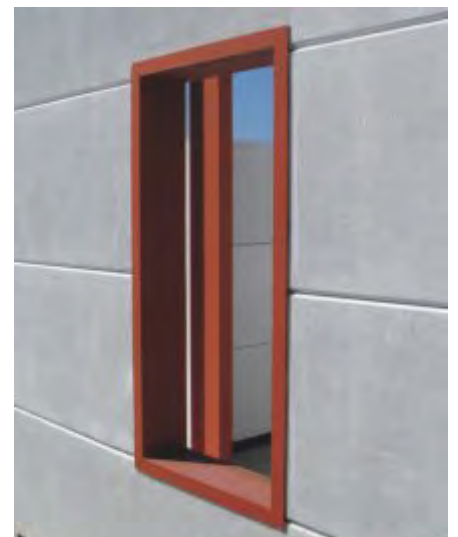
Fig. 29: Marco para vano de puertas o ventanas.
