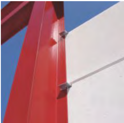
Fig. 12: Vista del conector "C" por el lado interior del muro.
