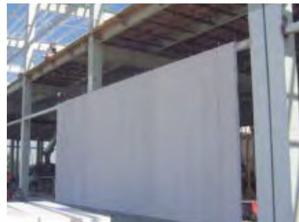
Fig. 21: Avance de la instalación de paneles en primera carrera.
