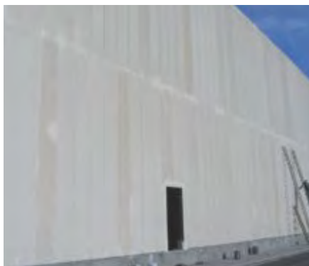
Fig. 26: Vista exterior antes del acabado final.
