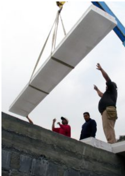
Fig. 4: Uso de eslingas de carga.
