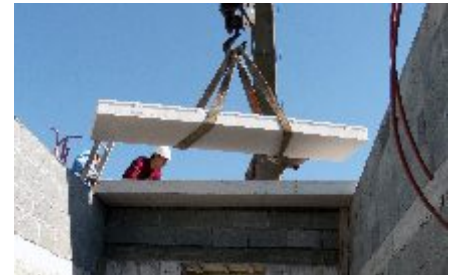
Fig. 8: Elevación de Panel de Losa.
