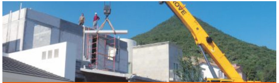
Fig. 7: Instalación de Panel de Azotea con eslinga.
