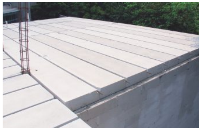
Fig. 12: Panel Hebel para losa de entrepiso.
