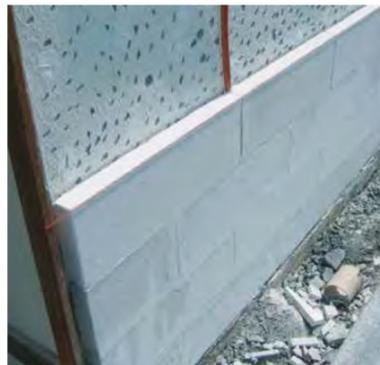
forma de "L" (10x5 cm), fijándose la sección de 10 cm en el muro existente mediante dos clavos para concreto o pija-taquete y en la placa termoaislante con clavo para madera.
