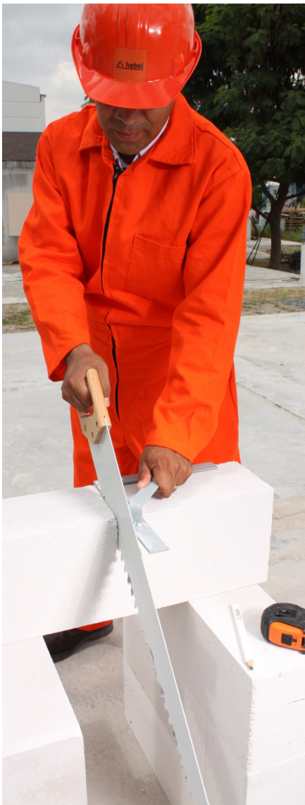
Fig. 16: Corte con serrucho y escuadra.
