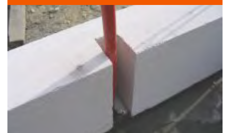
Fig. 22B: Resaque para tubería y mangueras.
