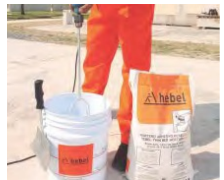
Fig. 6: Mezclado de Adhesivo Hebel.
