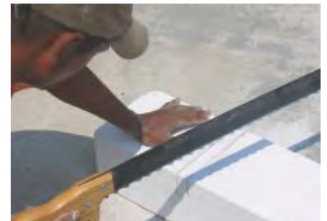
Fig. 22A: Corte con serrucho.
