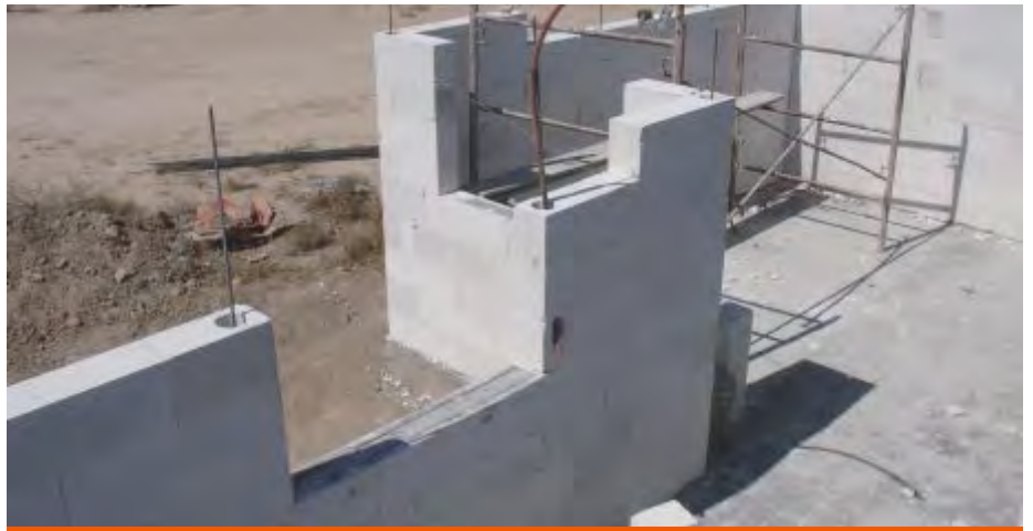
Fig. 26: Mampostería reforzada interiormente.
