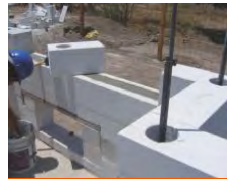
Fig. 21 Refuerzo vertical y horizontal de mampostería.
