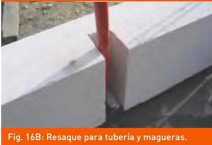
Fig. 16B: Resaque para tubería y mangueras.
