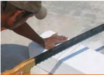
Fig. 16A: Corte con serrucho.
