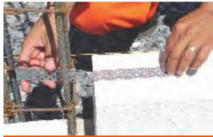
Fig. 10: Láminilla conectora.
