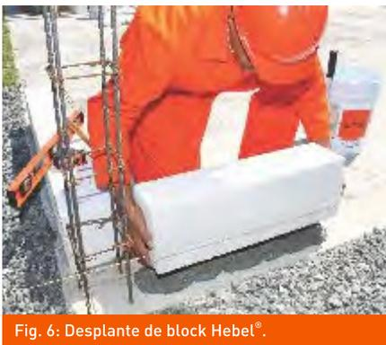
Fig. 6: Desplante de block Hebel®.
