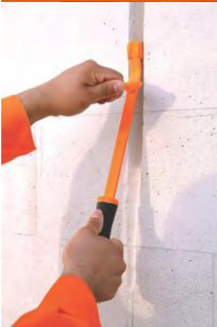
Fig. 16C: Ranurado para instalaciones de servicio.
