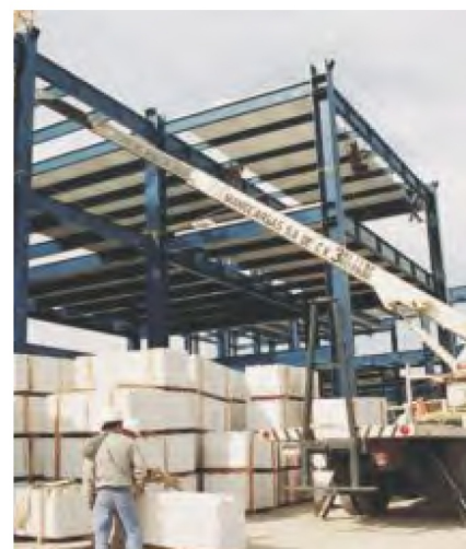
Fig. 2: Almacenamiento de panel Hebel en obra.
