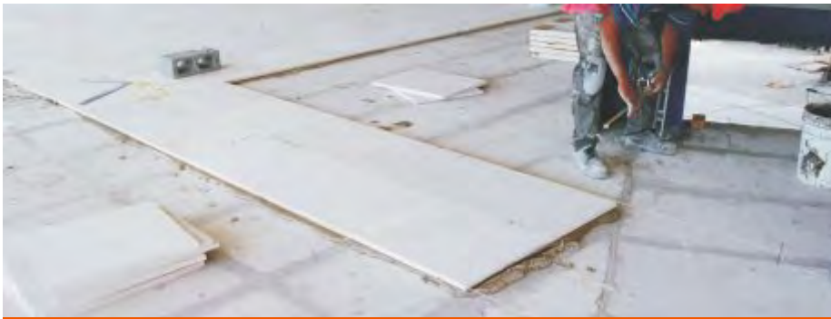
Fig. 21: Colocación directa de piso sobre panel Hebel.
