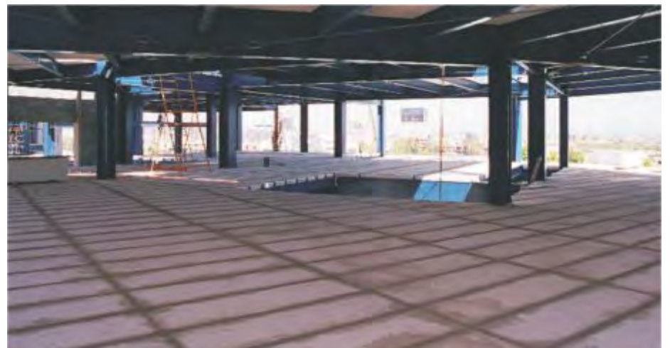
Fig. 25: Junta superior entre paneles coladas y afinadas.
