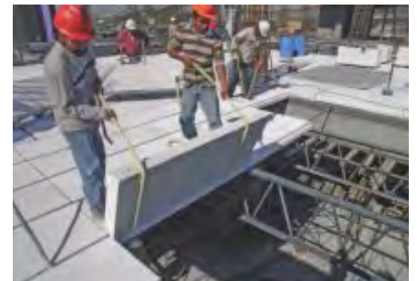
Fig. 8: Volteo del panel con cuerda (notese la posición del panel para facilitar la instalación).
