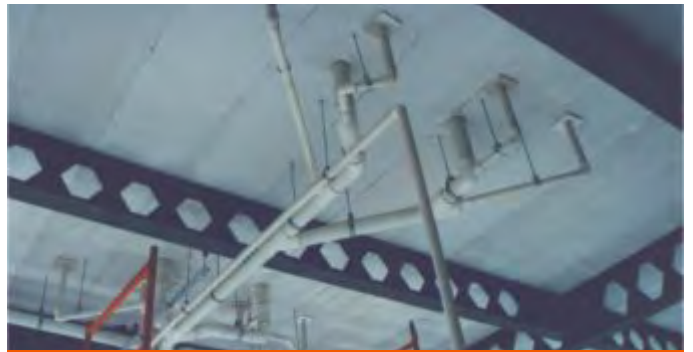
Fig. 20: Instalaciones sanitarias en nivel inferior de losa.
