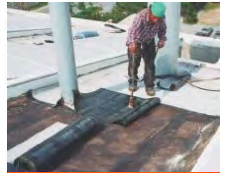
Fig. 22: Impermeabilización de membrana.
