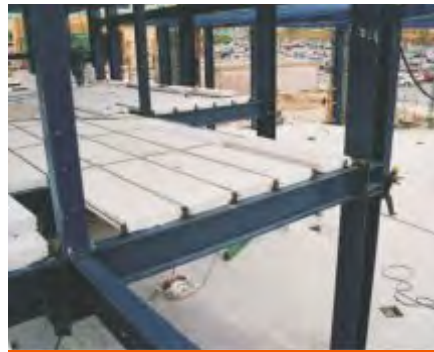
Fig. 14: Panel de entpiso sobre apoyos tipo IPR.
