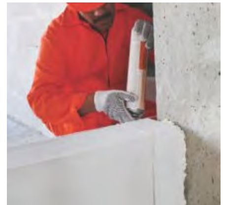
Fig. 5: Espuma Hebel en cara vertical.
