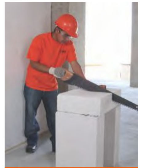
Fig. 9: Corte con serrucho Hebel.
