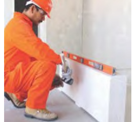
Fig. 4: Iniciar el desplante, colocando calzas.
