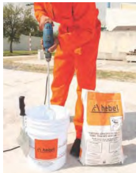
Fig. 2: Preparación de Adhesivo Hebel.
