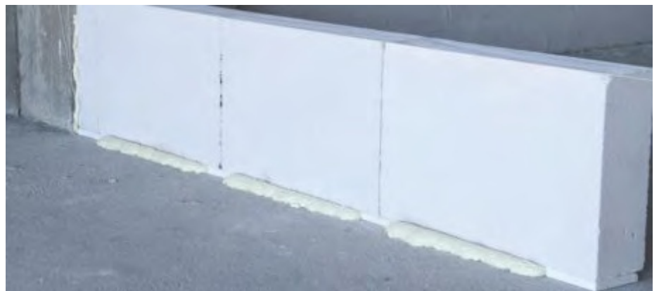
Fig. 6: Expansión de espuma de poliuretano en desplante.
