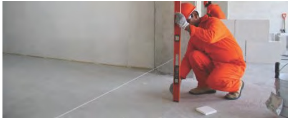
Fig. 3: Trazo y plomo para desplante.
