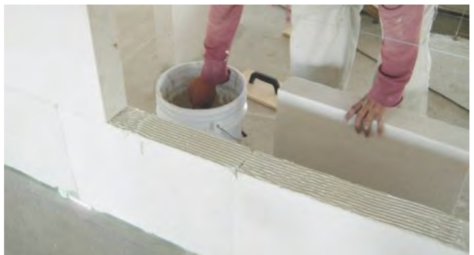
Fig. 8: Aplicación de Adhesivo Hebel.
