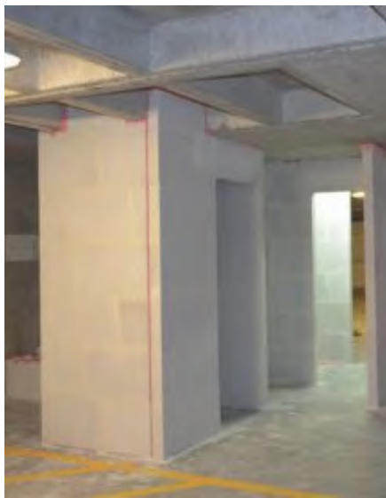
Fig. 17: Dintel y juntas de dilatación.
