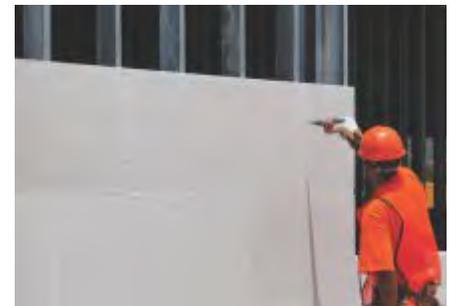
Fig. 13 Instalación de hiladas superiores.
