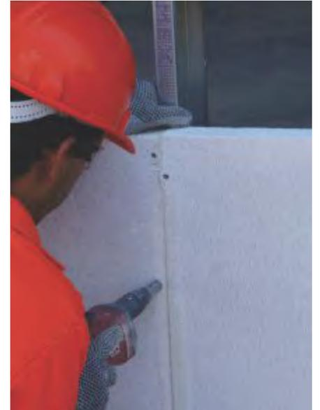
Fig. 11 Colocación de tornillos en unión.
