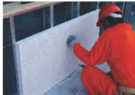
Fig. 10 Atornillado en postes centrales.
