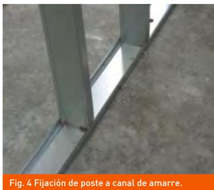
Fig. 4 Fijación de poste a canal de amarre.
