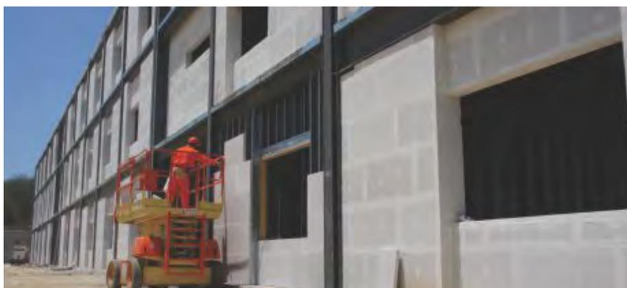
Fig. 18 Tablero de Hebel® Power Panel instalado.
