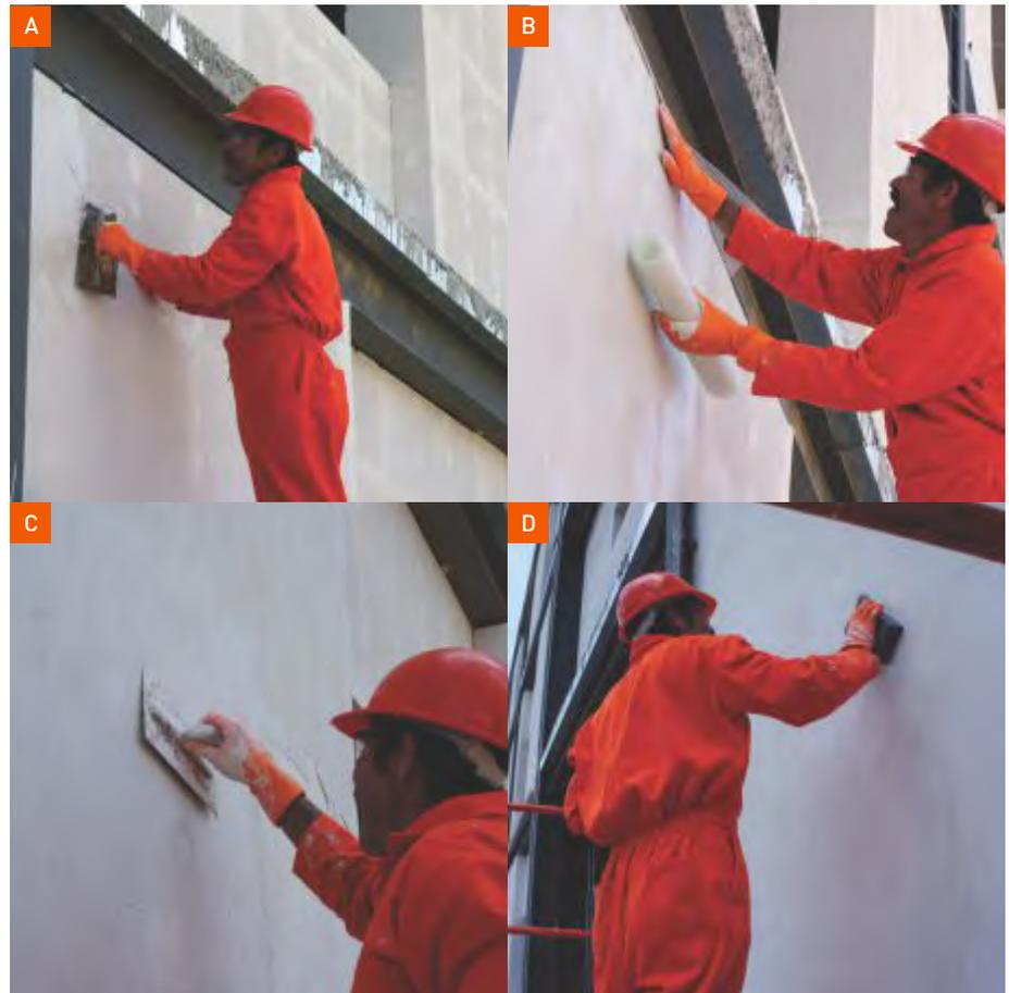
Fig. 23 Aplicación de Malla embebida en Adhesivo, y Acabado Estuco.
