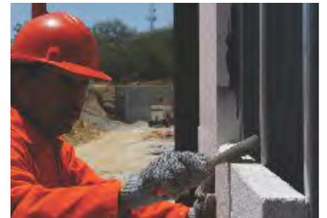
Fig. 12 Adhesivo entre paneles.
