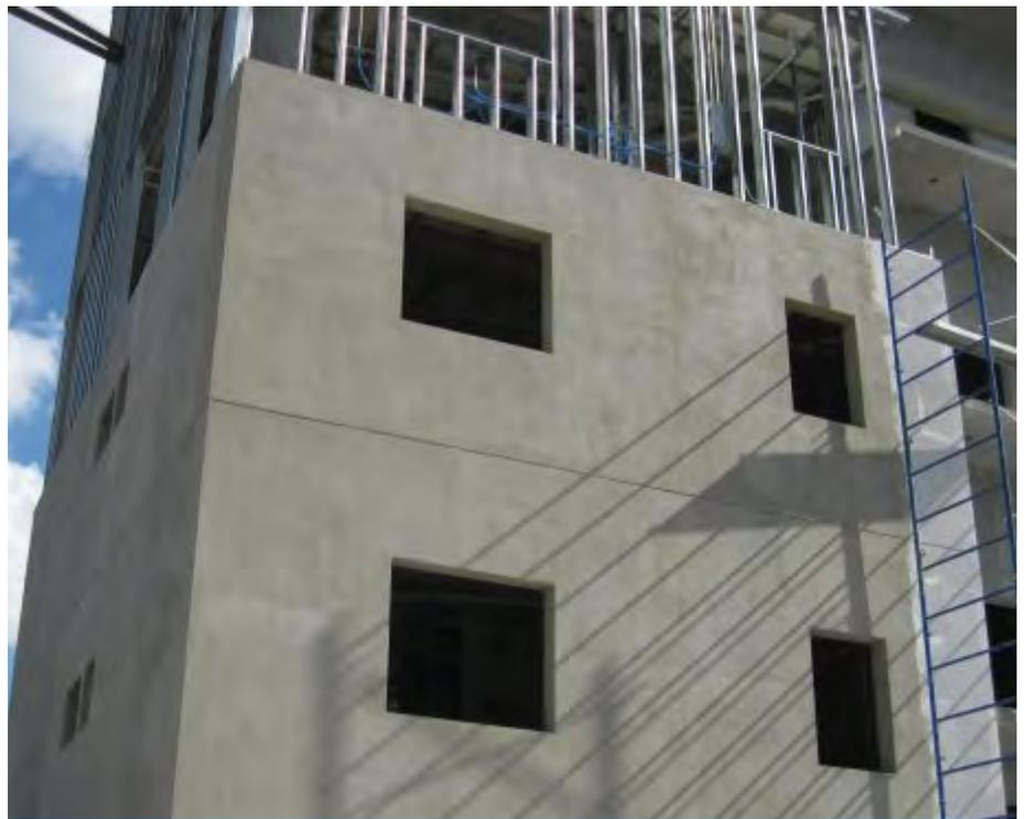
Fig. 19 Tablero de Hebel® Power Panel con acabado.
