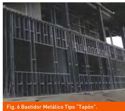
Fig. 6 Bastidor Metálico Tipo "Tapón".
