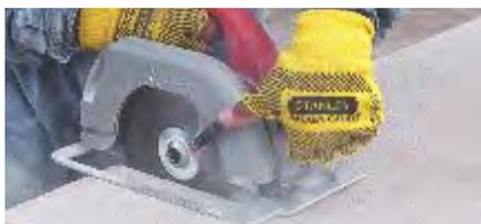
Fig. 14 Corte de Hebel® Power Panel.
