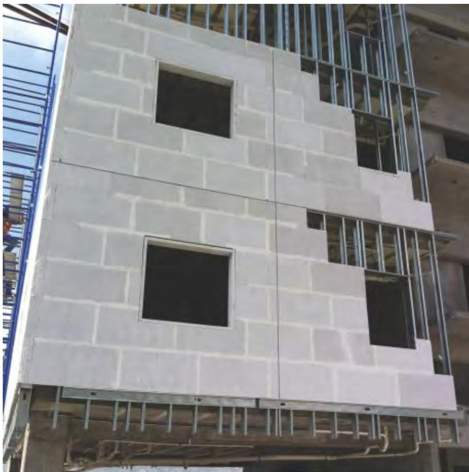
Fig. 17 Detalle remate en ventana y juntas entre tableros.
