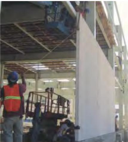
Fig. 17: Nivelar, alinear y plomear cada panel.
