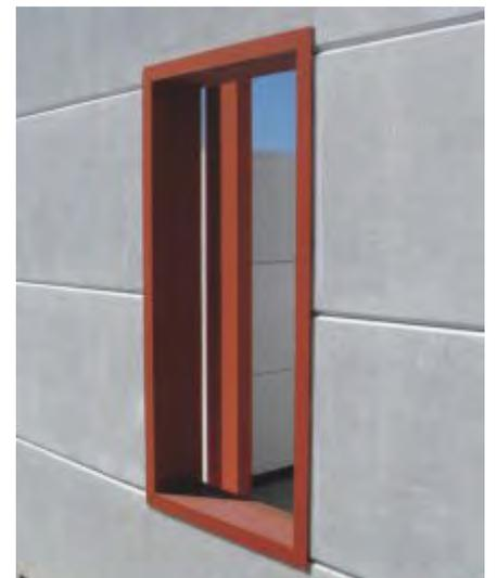
Fig. 29: Marco para vano de puertas o ventanas.
