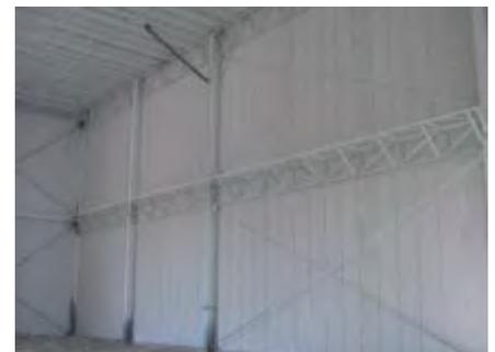
Fig. 22: Vista interior de panel en arreglo vertical.
