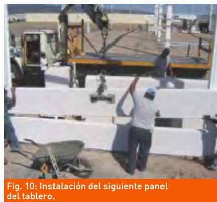
Fig. 10: Instalación del siguiente panel del tablero.
