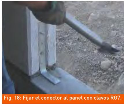
Fig. 18: Fijar el conector al panel con clavos RG7.
