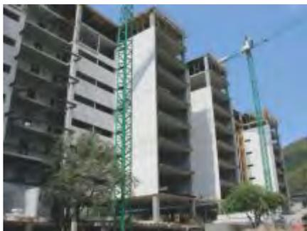
Fig. 30: Panel Hebel para muro en proyectos comerciales.
