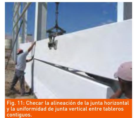
Fig. 11: Checar la alineación de la junta horizontal y la uniformidad de junta vertical entre tableros contiguos.
