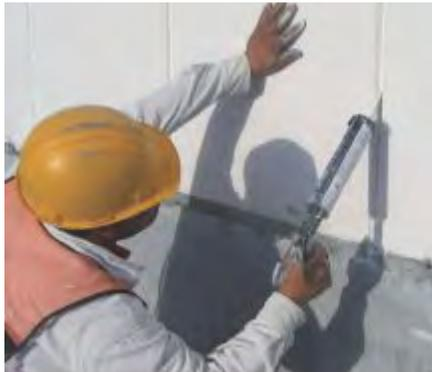
Fig. 24: Sellado de junta vertical exterior entre paneles.
