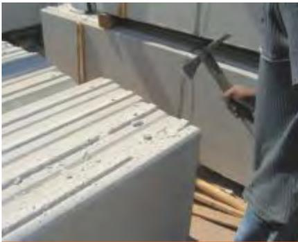
Fig. 7: Desbastar la sección macho en los extremos del panel.
