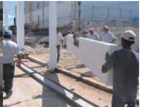
5. Colocar la tenaza tijera al centro de la longitud del panel (lado macho), liberar el seguro de la tenaza, izar y mover el panel a su posición de instalación. Colocar el panel sobre una capa semi-seca de mortero cemento-arena (sólo para el panel de desplante). Verificar el apoyo mínimo y la correcta nivelación del panel, si es necesario se puede utilizar calzas temporales de plástico o madera.
