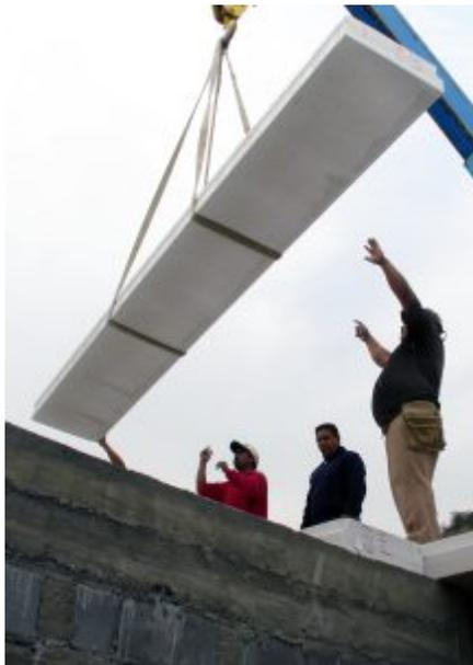
Fig. 4: Uso de eslingas de carga.
