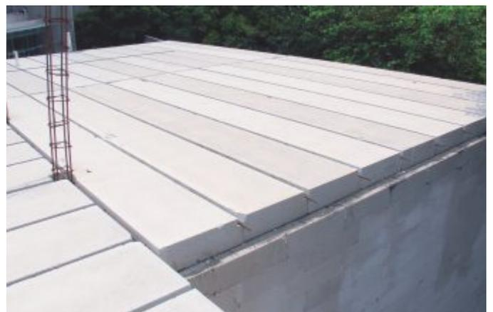
Fig. 12: Panel Hebel para losa de entrepiso.
