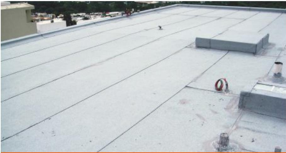
Fig. 17: Impermeabilizante tipo membrana SBS.
