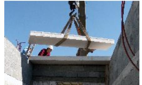
Fig. 8: Elevación de Panel de Losa.
