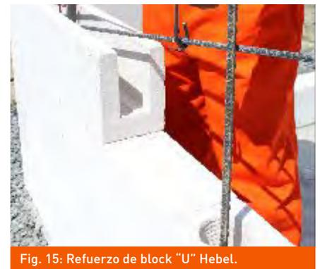
Fig. 15: Refuerzo de block "U" Hebel.
