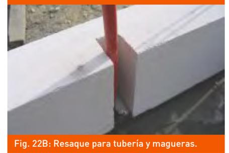
Fig. 22B: Resaque para tubería y mangueras.
