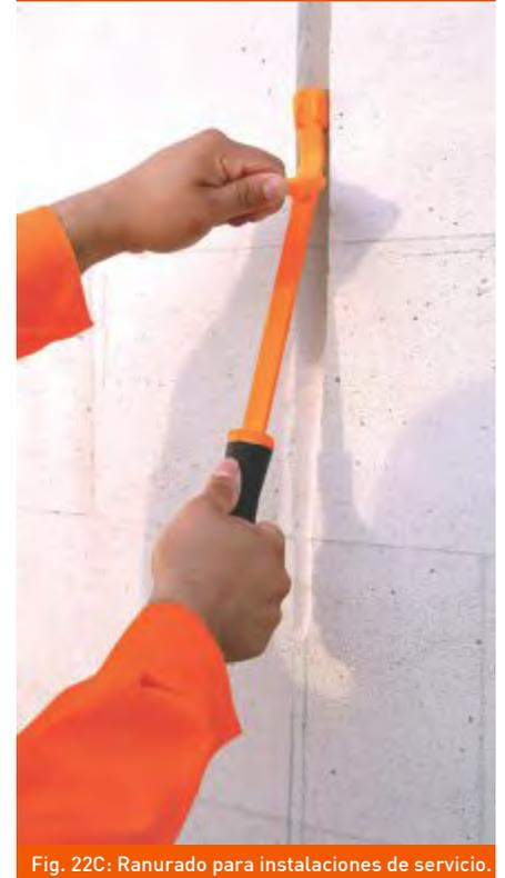
Fig. 22C: Ranurado para instalaciones de servicio.
