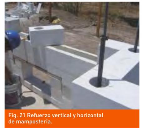
Fig. 21 Refuerzo vertical y horizontal de mampostería.
