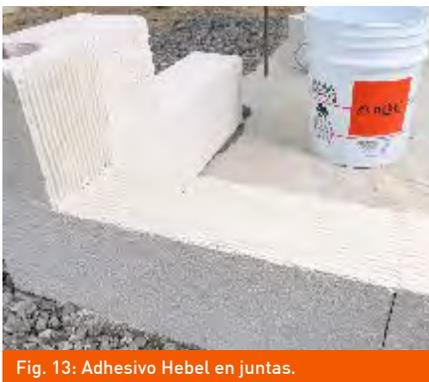
Fig. 13: Adhesivo Hebel en juntas.
