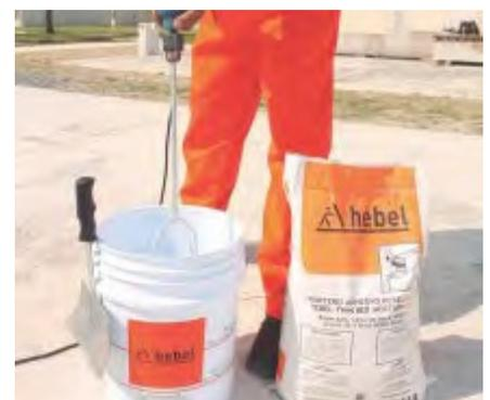
Fig. 6: Mezclado de Adhesivo Hebel.
