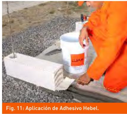
Fig. 11: Aplicación de Adhesivo Hebel.
