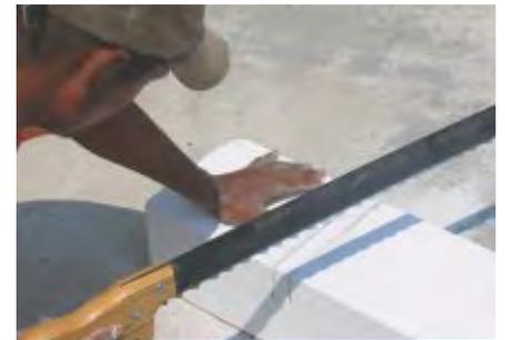
Fig. 22A: Corte con serrucho.
