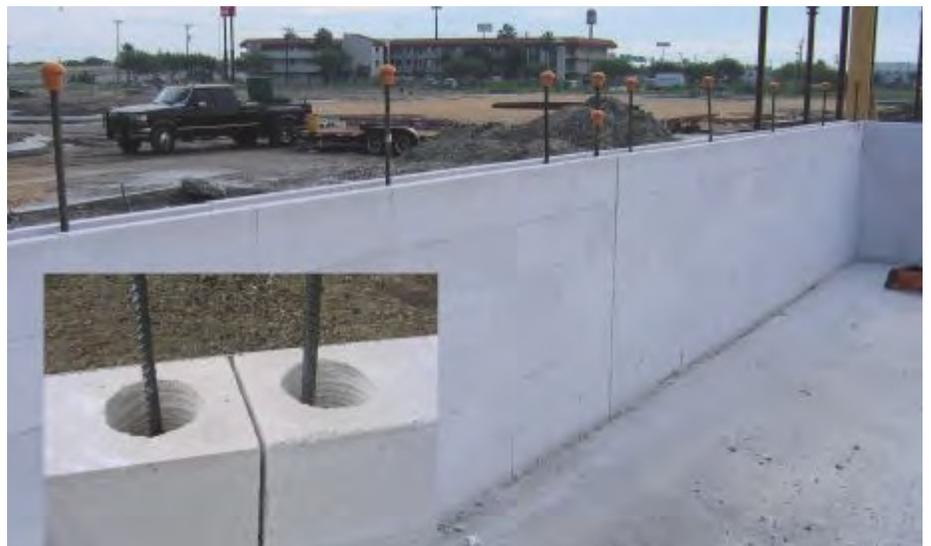
Fig. 17: Junta de control en muro.
