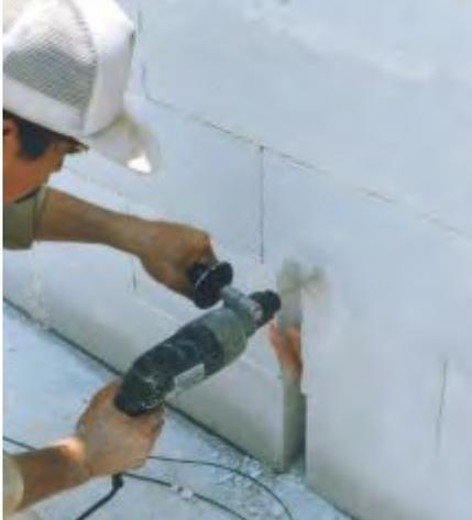
Fig. 24: Ranurador circular para contactos y salidas eléctricas.
