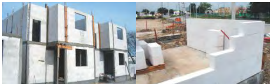
Fig. 15: Mampostería Confinada Hebel®.
