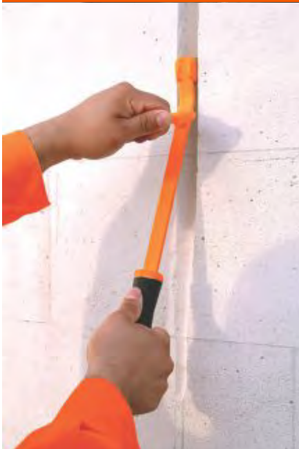
Fig. 16C: Ranurado para instalaciones de servicio.
