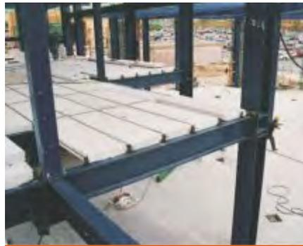
Fig. 14: Panel de entpiso sobre apoyos tipo IPR.
