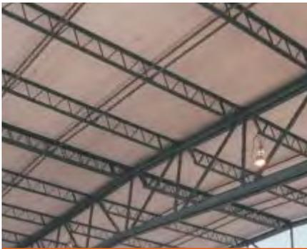
Fig. 13: Panel de cubierta sobre apoyos tipo Joist.
