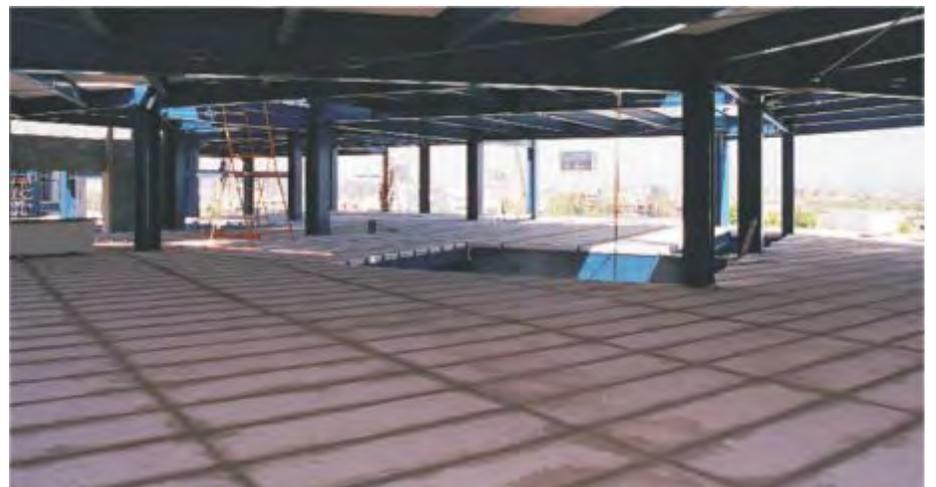
Fig. 25: Junta superior entre paneles colados y afinados.
