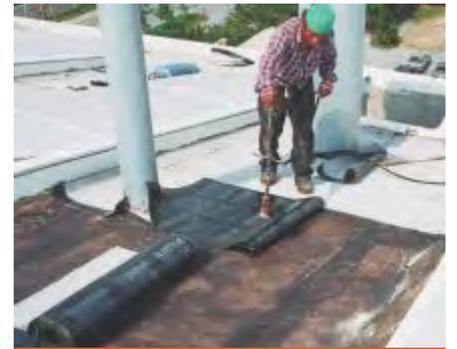
Fig. 22: Impermeabilización de membrana.
