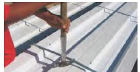
Fig. 4: Desflejado de paquetes de paneles.
