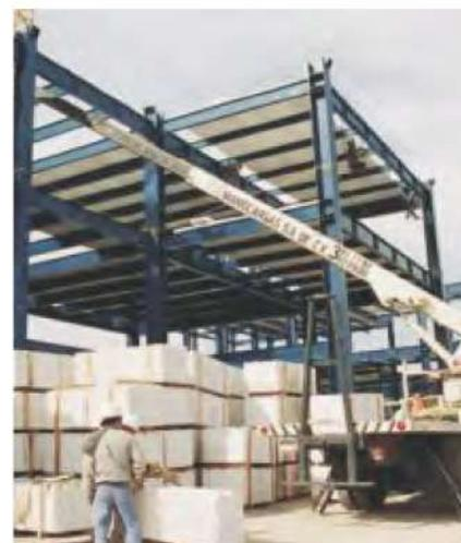
Fig. 2: Almacenamiento de panel Hebel en obra.
