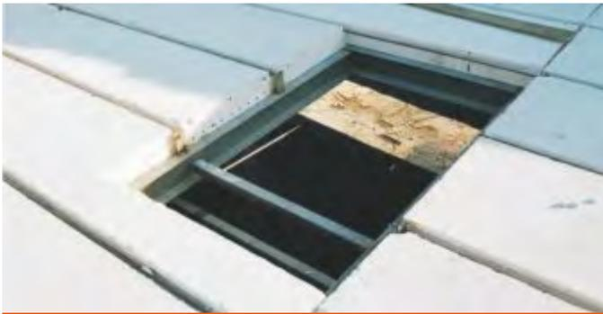
Fig. 19: Hueco en losa para domos o instalaciones.
