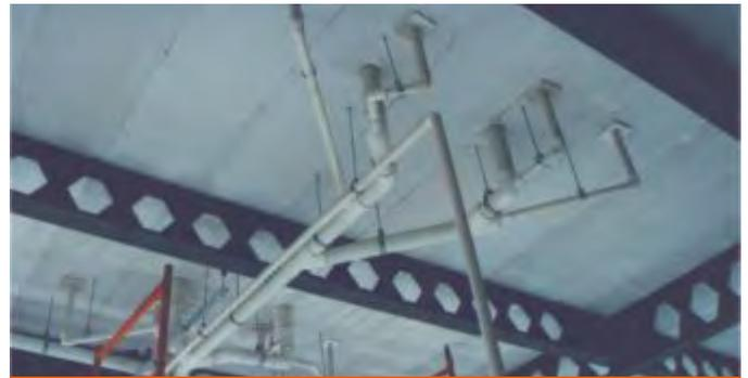
Fig. 20: Instalaciones sanitarias en nivel inferior de losa.
