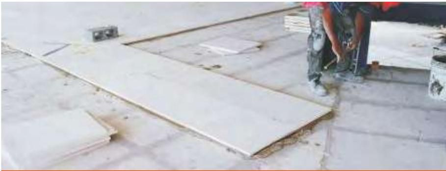
Fig. 21: Colocación directa de piso sobre panel Hebel.
