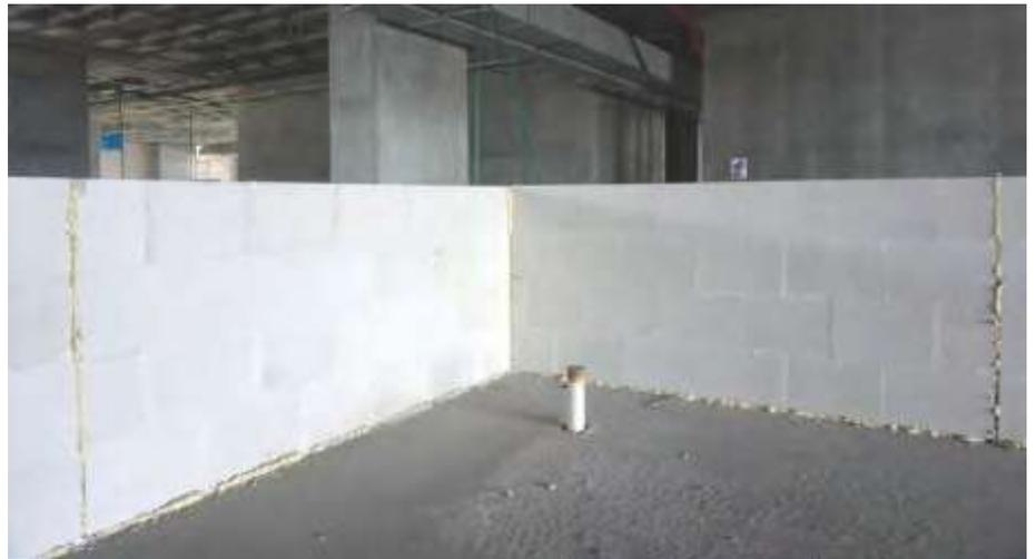
Fig. 7: Junta de control a cada 15 m<sup>2</sup> de muro.
