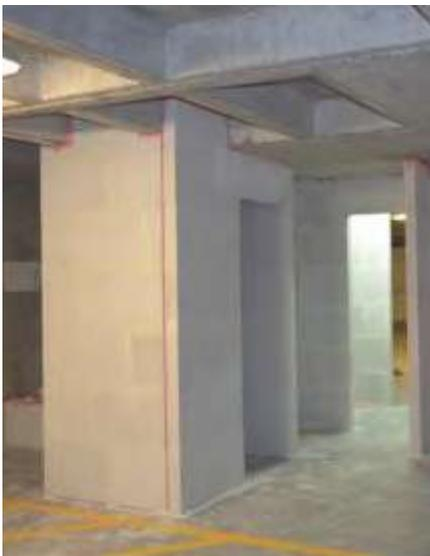
Fig. 17: Dintel y juntas de dilatación.
