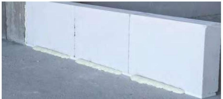
Fig. 6: Expansión de espuma de poliuretano en desplante.
