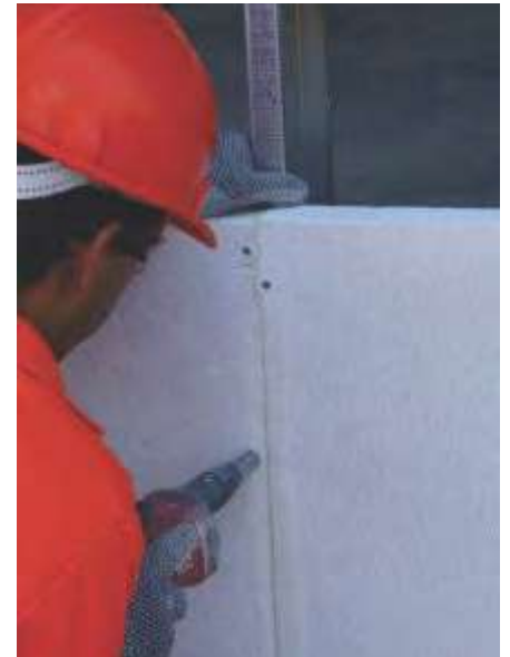
Fig. 11 Colocación de tornillos en unión.
