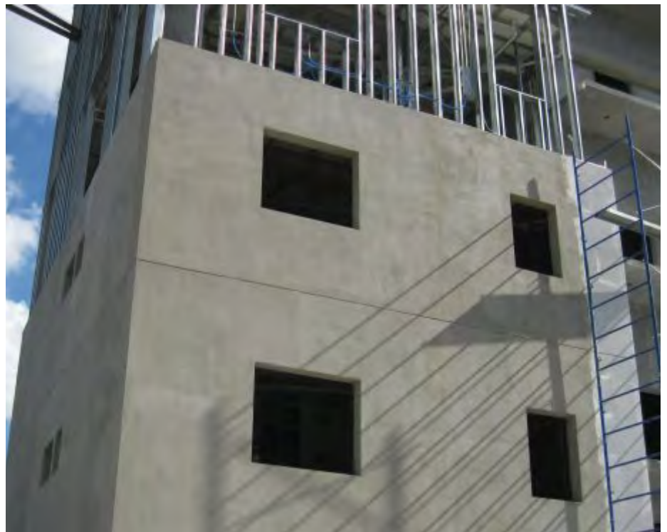
Fig. 19 Tablero de Hebel® Power Panel con acabado.
