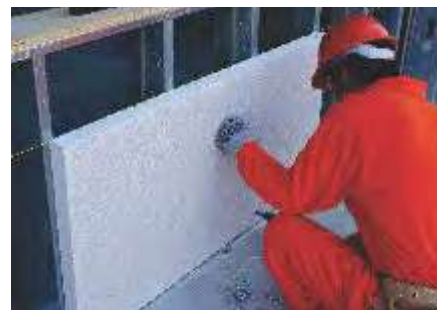
Fig. 10 Atornillado en postes centrales.
