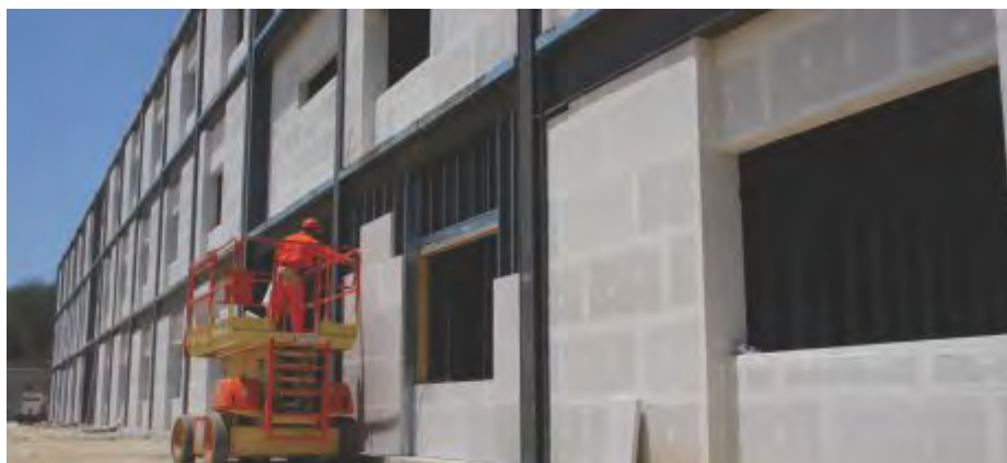
Fig. 18 Tablero de Hebel® Power Panel instalado.
