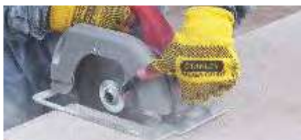
Fig. 14 Corte de Hebel® Power Panel.
