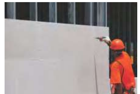
Fig. 13 Instalación de hiladas superiores.
