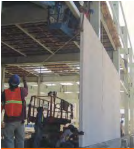
Fig. 17: Nivelar, alinear y plomear cada panel.
