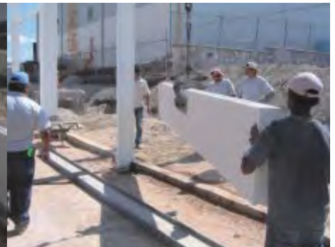
Fig. 8a / 8b: Colocar la tenaza al centro del panel y moverlo a la posición de instalación.
