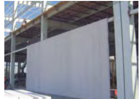
Fig. 21: Avance de la instalación de paneles en primera carrera.
