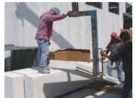
Fig. 15: Colocación del gancho G90 por el lado macho.
