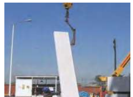
Fig. 16: Izar lentamente el panel hasta la posición de instalación.
