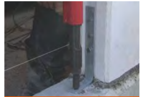
Fig. 19: Fijar el conector a la viga de apoyo de concreto.
