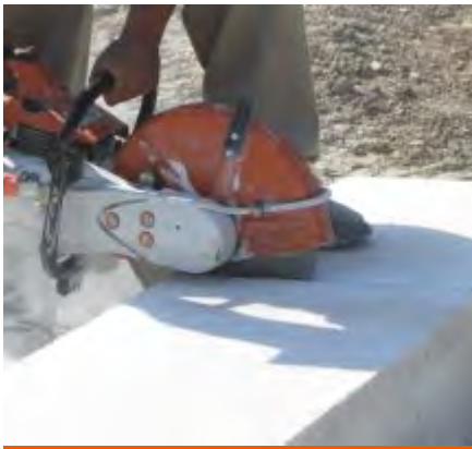
Fig. 27: Corte de panel con equipo portátil eléctrico o a gasolina.
