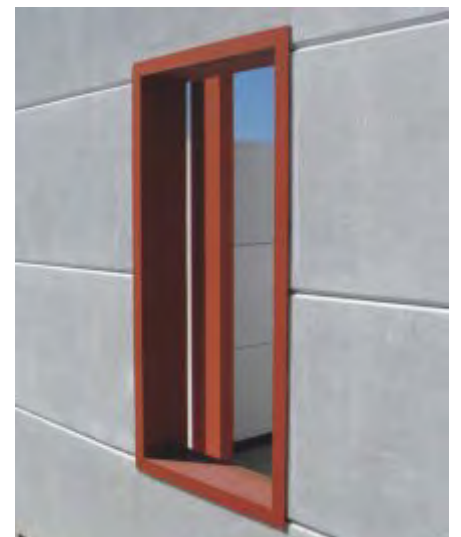
Fig. 29: Marco para vano de puertas o ventanas.
