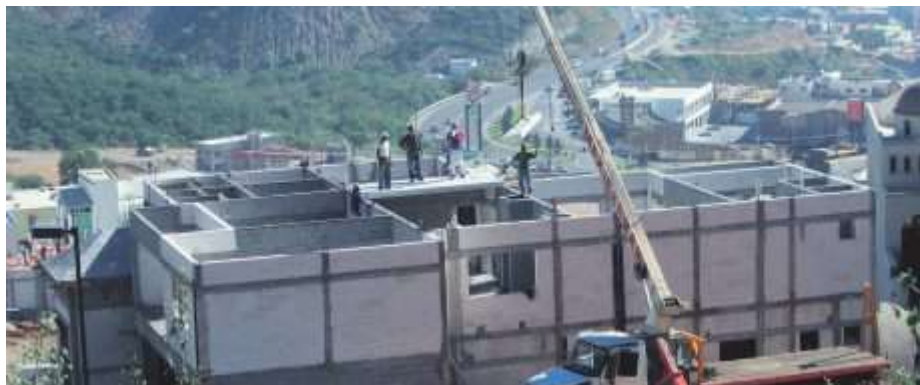
Fig. 3: Checar equipo y logística de montaje.
