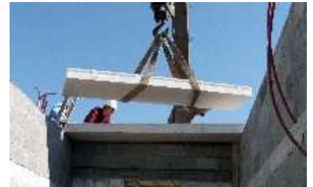
Fig. 8: Elevación de Panel de Losa.
