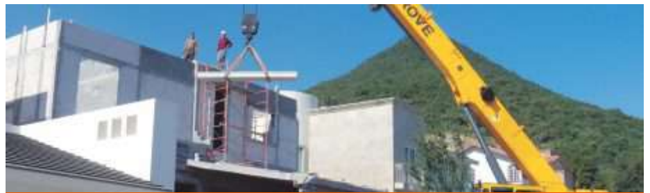
Fig. 7: Instalación de Panel de Azotea con eslinga.
