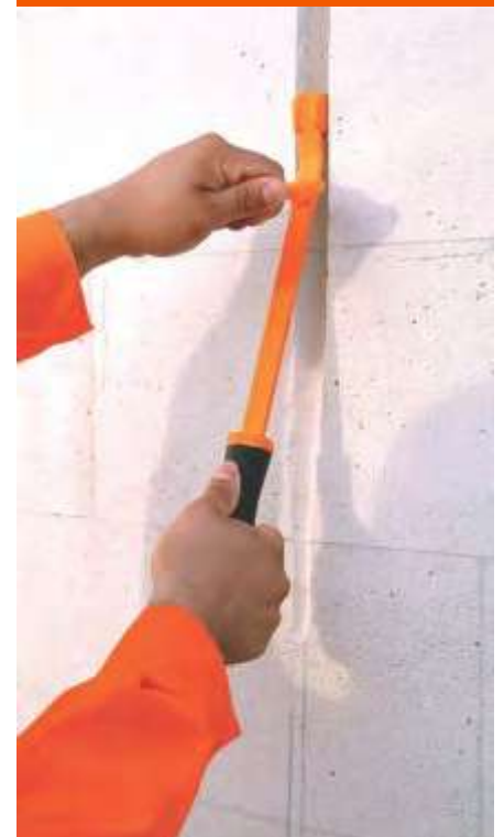
Fig. 22C: Ranurado para instalaciones de servicio.
