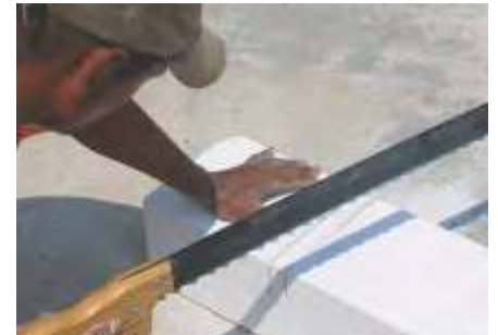
Fig. 22A: Corte con serrucho.
