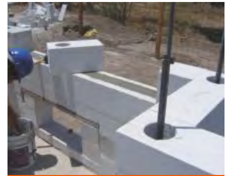
Fig. 21 Refuerzo vertical y horizontal de mampostería.
