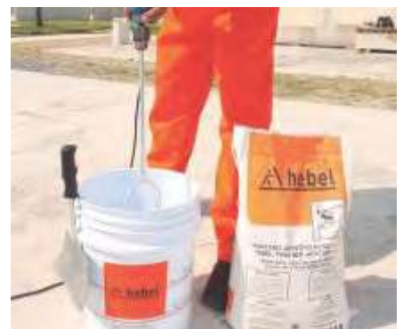
Fig. 6: Mezclado de Adhesivo Hebel.
