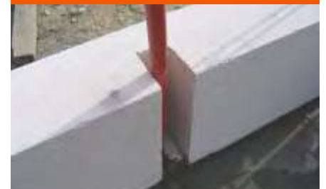
Fig. 22B: Resaque para tubería y mangueras.
