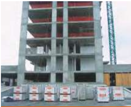
Fig. 4: Pallets de block Hebel en almacén de obra.
