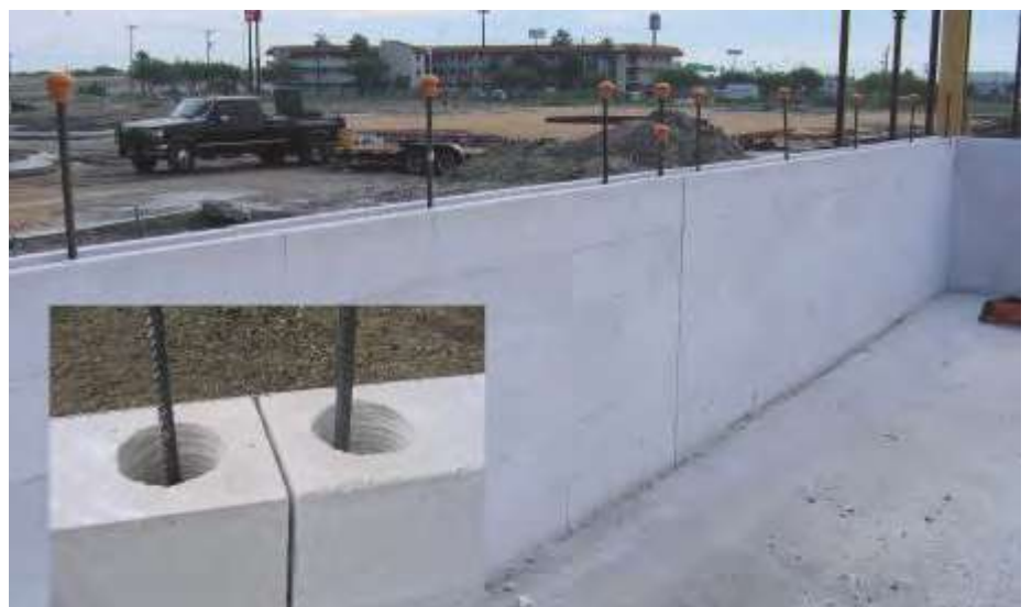
Fig. 17: Junta de control en muro.
