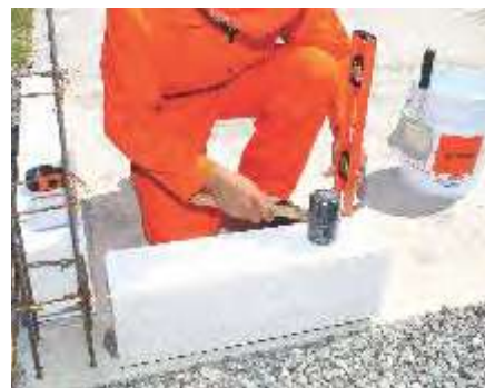
Fig. 7: Nivelando con mazo de goma.
