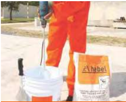
Fig. 5: Mezclado de Adhesivo Hebel®.
