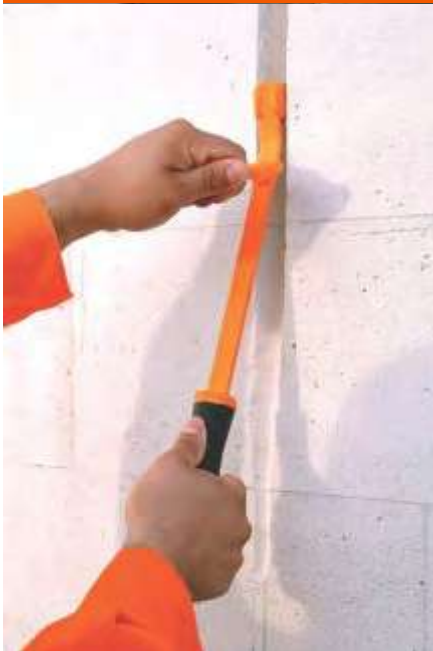
Fig. 16C: Ranurado para instalaciones de servicio.
