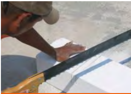
Fig. 16A: Corte con serrucho.
