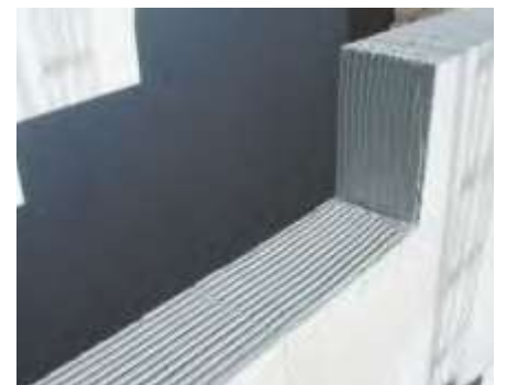
Fig. 8: Adhesivo aplicado en cara horizontal y vertical (a todo lo largo y ancho del block).
