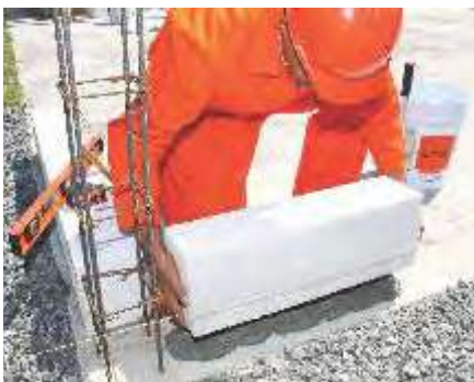
Fig. 6: Desplante de block Hebel®.
