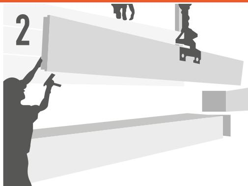
Mediante grúa y eslingas se elevará el panel y se llevará hasta su zona de colocación.
